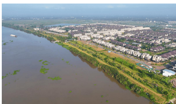
Hình 9. Dự án Waterpoint
