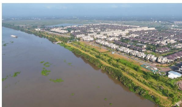
Hình 9. Dự án Waterpoint
